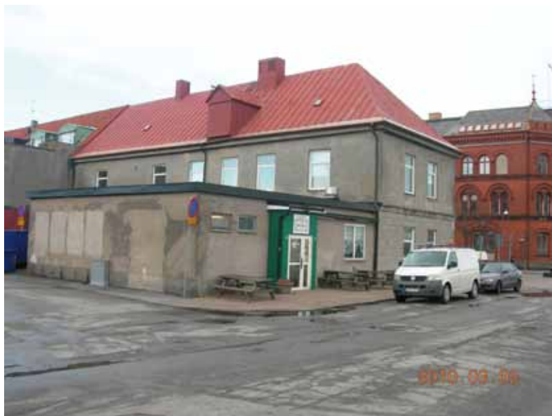
Gamla hamnkonto- ret fick en pietets- full renovering.
