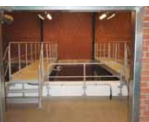
Nedraby vattenverk fick ny filterbyggnad.
