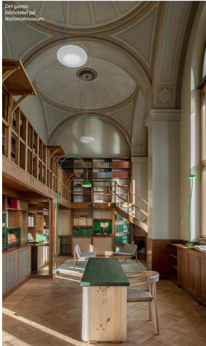
I takkupolernas rosetter sitter en inbyggd sprinkler.
